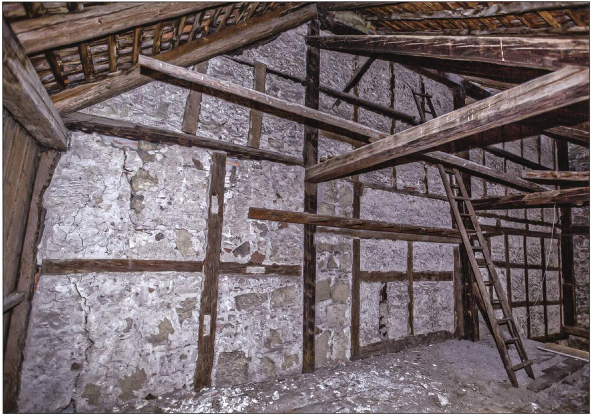
Abb. 3 Südansicht der nachträglich in mehreren Phasen entstandenen Riegelwand im Dachstuhl zwischen dem Wohn- und dem Ökonomietrakt (18./19. Jahrhundert). Die darin eingelassenen, rauchschwarzen Ständer und Verstreben gehören zur Firstständerkonstruktion von 1462/63. Foto Theo Frey
