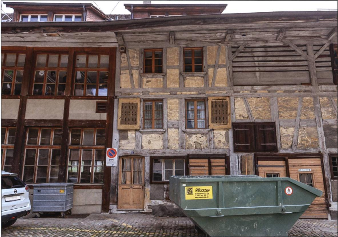
Abb. 7 Ansicht der Nordfassade der Liegenschaften Letzigasse 10 und 12. Rechts die ursprüngliche Riegel-Bohlen-Konstruktion, links die im 20. Jahrhundert erneuerte Fassade der abpartzellierten Wohntrakthälfte.
