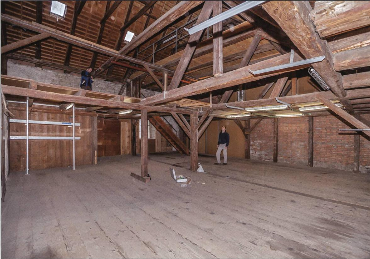
Abb. 6 Blick in die Scheune Pfistergasse 42 während der dendrochronologischen Beprobung der Ständerkonstruktion. Ansicht von Osten. Foto Cecilie Gut
