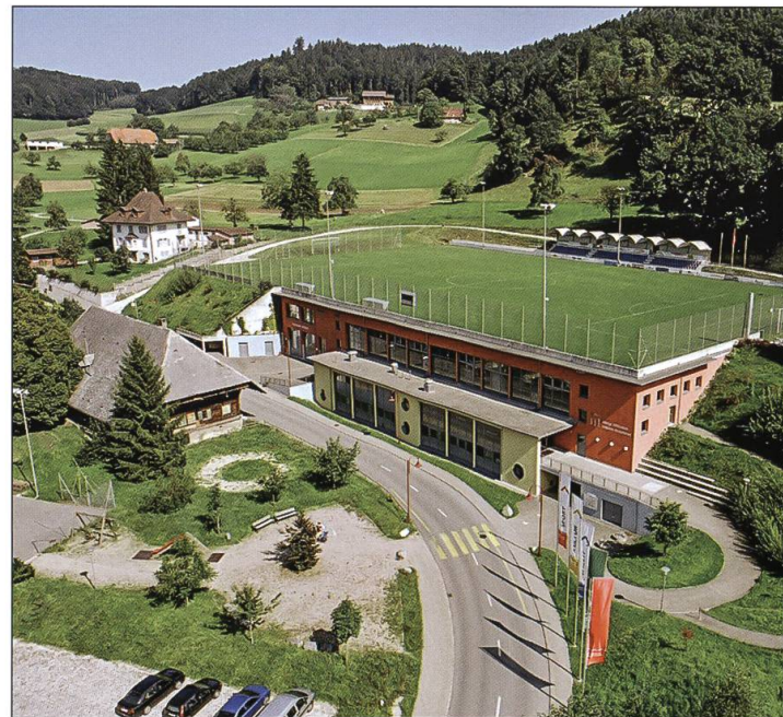
Mehrzweckanlage Hiltbrunnen mit Feuerwehrmagazin und Sportplatz.
