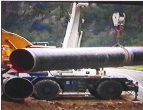
Tonnenschwere Einzelrohre werden ab regionalen Depots hertransportiert.
