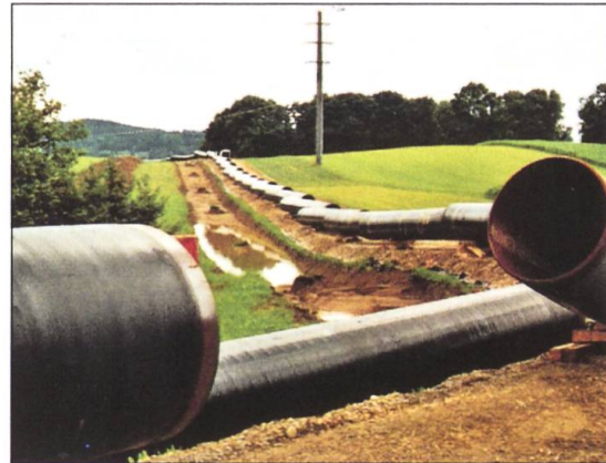
Einzelrohre bereit zum Verschweissen entlang des Leitungsgrabens.
