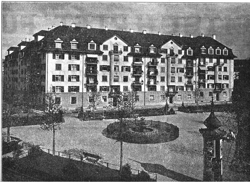
Bauten der Allgemeinen Baugenossenschaft Luzern
