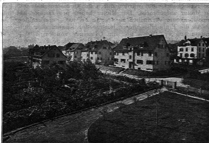
Mehrfamilienhäuser der Gemeinnützigen Baugenossenschaft Thalwil
