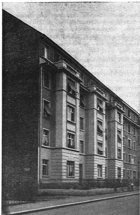
Abb. 1. Miethaus von der Strassenseite
