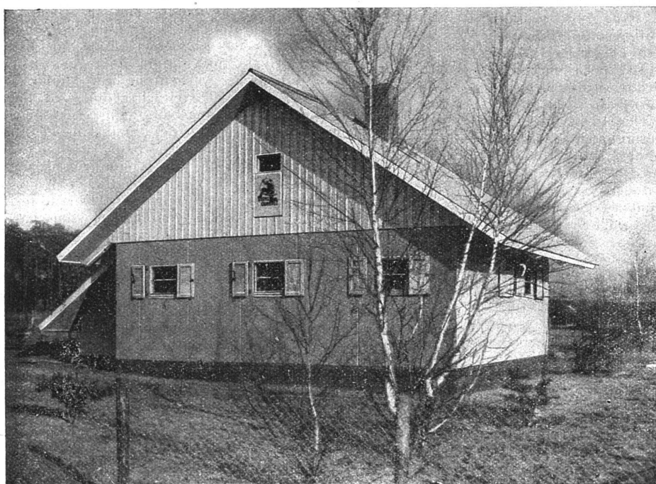
Das fertige Stahllamellen-Siedlungshaus
