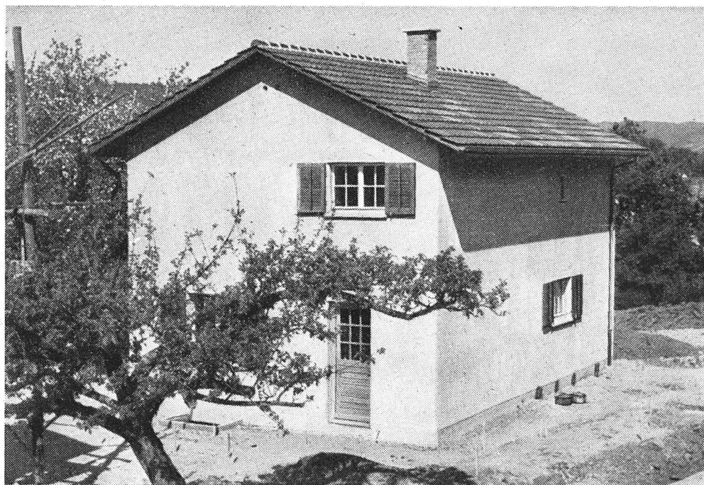
Eigenheimgenossenschaft, Kolonie Schloßhof, Ansicht mit Schopfeingang
