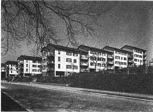
Baugenossenschaft Eidg. Personal, Zürich
