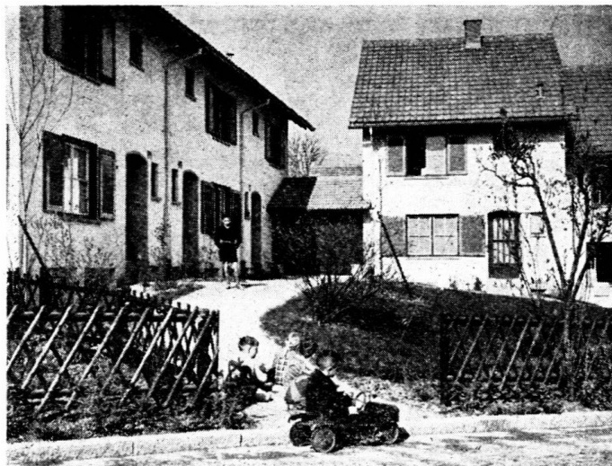
Blick in einen reizenden, durch einen niedrigen Schopf-Zwischenbau verbundenen Winkel.
