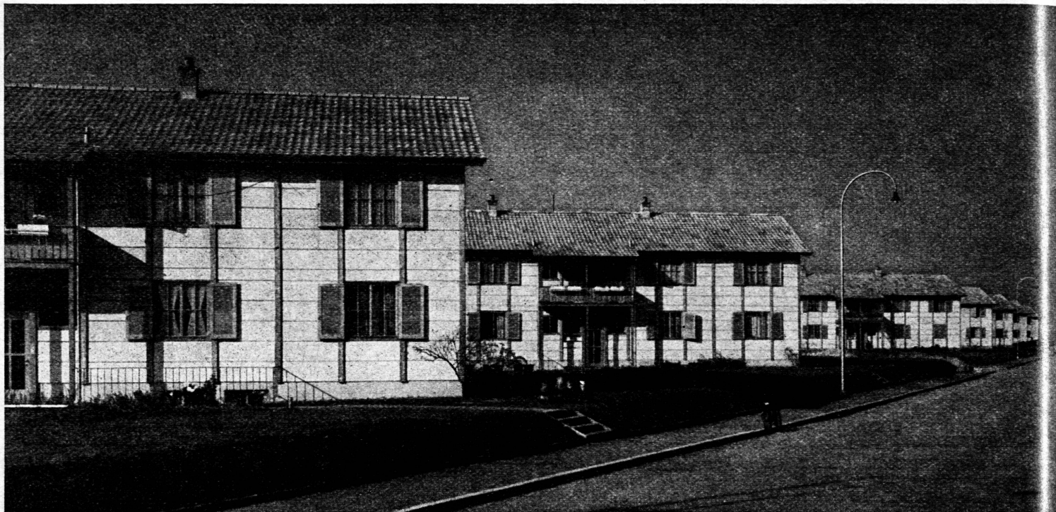
Gesamtansicht von der Neudorfstraße aus
