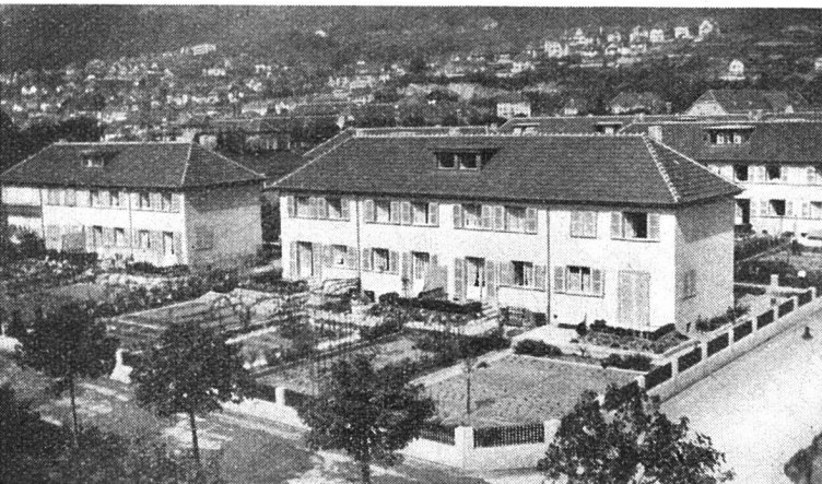
Einfamilienhäuser der Kolonie «Champagne» Erstellt 1929
