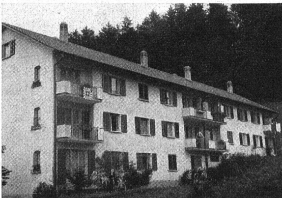
Obige Photographien wurden uns in freundlicher Weise von Herrn Architekt Theo Hochstrasser in Zug zur Verfügung gestellt
