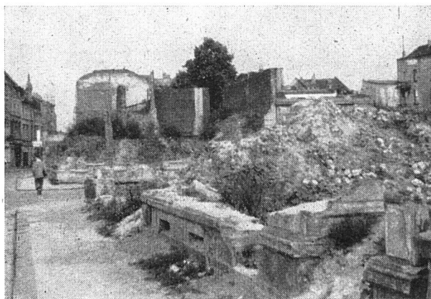
Ganze Stadtteile liegen in Trümmern. In diesen Steinhaufen versteckt liegt das Hotel «Rheinland» in Düsseldorf
