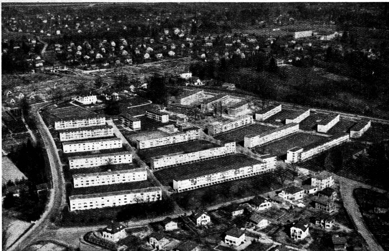
Gesamtansicht der fünf Bauetappen der «Société Coopérative d'Habitation de Genève»
