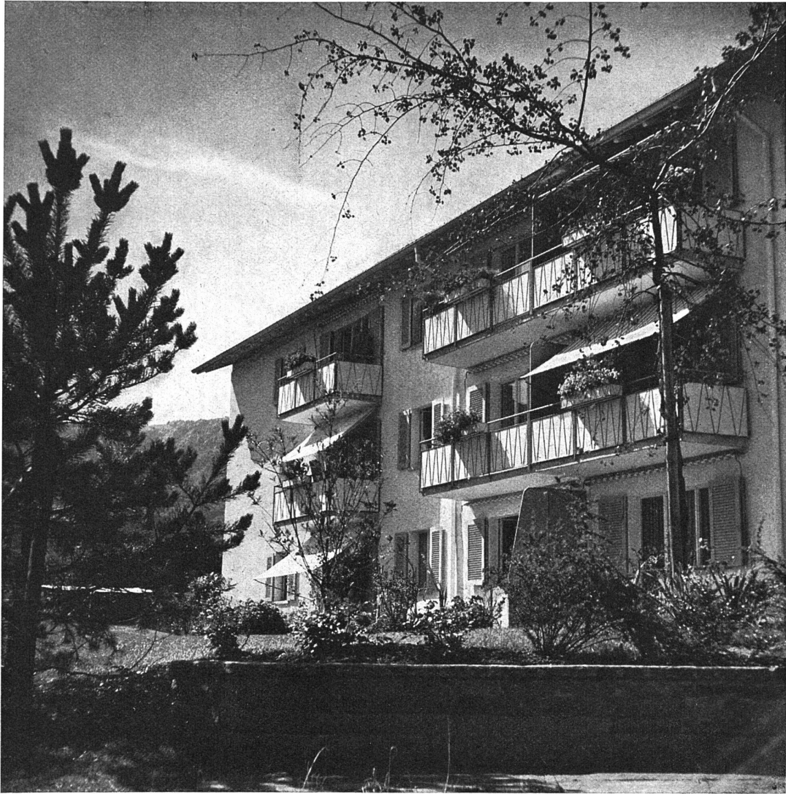
Teilansicht der 9. Bauetappe Fellenberg-/Langgrütstraße
