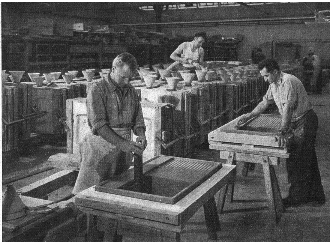
Die Apparate erhalten ihre Form durch das Ausgießen von Hohlformen aus Gips. Im Vordergrund unser Schüttstein «Linth».
