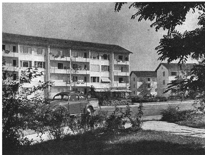
BGZ Baugenossenschaft Glattal Zürich
