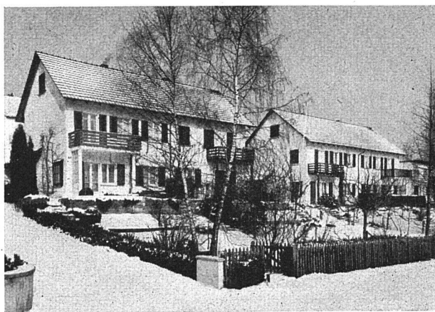
Wohnbaugenossenschaft Olten und Umgebung, Gallusstraße
