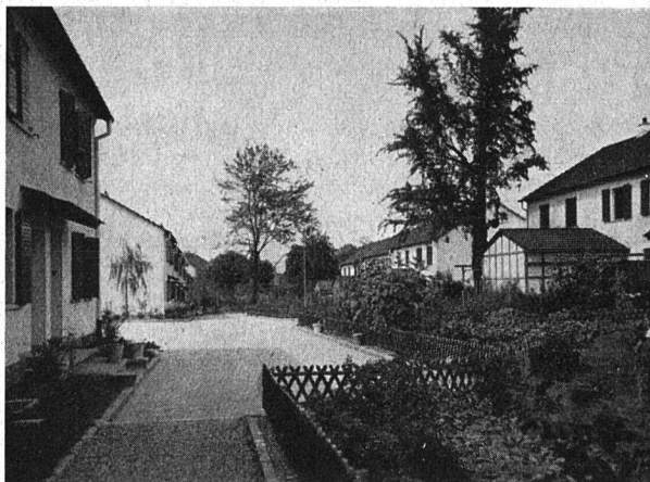
Einfamilienhäuser der Wohngenossenschaft «Zur Eiche» in Basel
