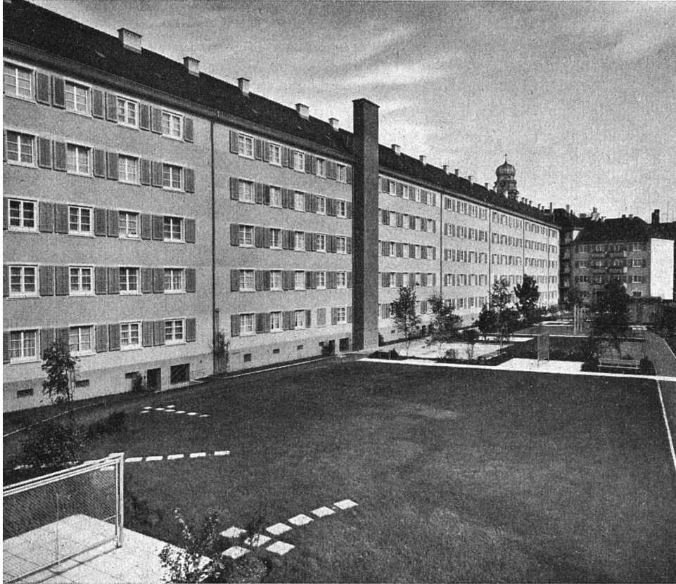
Die lange und eintönige Hoffassade, die einen hellen Farbton erhielt, wird durch das dunkel gehaltene Hochkamin und die Dachablaufrohre angenehm unterbrochen.
