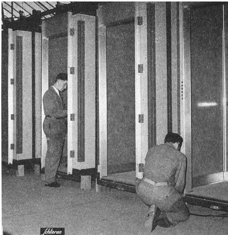
Aufzugskabinen des Econom -Aufzuges auf der Montagelinie. Die Verwendung von genormten und bewährten Bauteilen sowie die Seriefabrikation des Econom -Aufzuges ermöglichen einen günstigen Verkaufspreis und eine kurze Lieferfrist, was vor allem bei Wohnbauten den Einbau von Aufzügen begünstigt wird.
