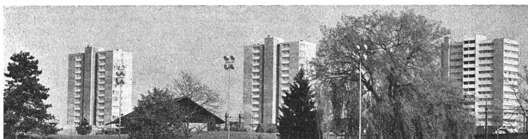
Drei Wohnhochhäuser der Siedlung Außerholligen in Bern
