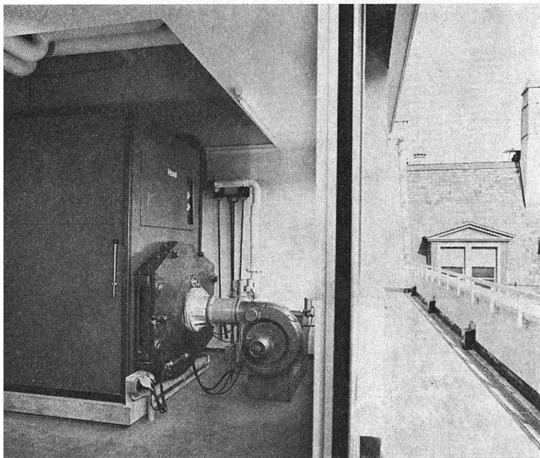
Gaszentralheizung auf dem Dach einer neuen Liegenschaft an der Bahnhofstrasse 22/24 in Zürich. Durch die Installation auf dem Dach wird wertvoller Raum im Keller gewonnen, und auch das störende und platzbeanspruchende Kamin fällt weg. Gasheizung hat auch den Vorteil, dass sie keinen Lager- und Tankraum benötigt. Probleme des Grundwassers konnten in diesem Fall elegant umgangen werden. Die Heizzentrale besteht aus Hoval-Kesseln TKD-R 700 und Elco-Gebläsegasbrenner UDG 6 A.
