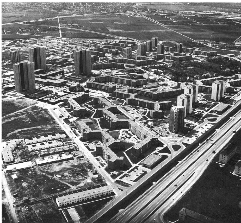
Die Photos auf dieser Seite vermitteln einige Impressionen des riesigen Baugebietes von Mannheim-Vogelstang
