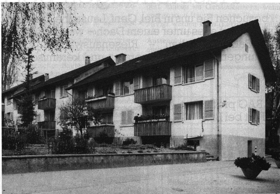
Die Fotos zeigen Beispiele aus den Überbauungen der Wohnbaugenossenschaft «Daheim» vor (oben und unten) und nach der Renovation (gegenüberliegende Seite).
