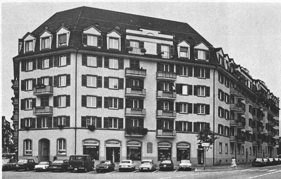
Siedlung Himmelrich 2, Baujahr 1927
