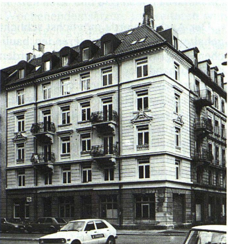
Von oben: Fassade vor der Renovation. Photo: M. Rüegg-Reinhardt
