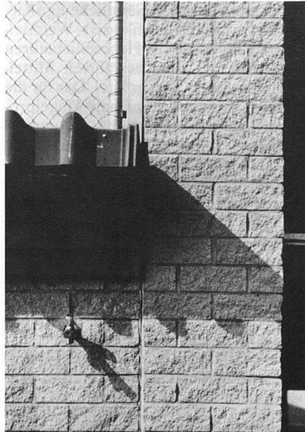
Ebenfalls neu im Verkaufssortiment der Hard AG sind vorfabrizierte Sichtmauerwerkstürze, die sich homogen in das Mauerwerk einfügen. Am Ausstellungsstand der Hard AG, Volketswil, finden Bauherren, Planer und Ausführende Anregungen und wichtige Details über Kalksandsteine. Interessant auch: Mit einem Computer werden Wandkonstruktionen mit Kalksandsteinen oder auch anderen Baustoffen bezüglich ihrer Funktionstüchtigkeit geprüft, bauphysikalisch berechnet und ausgewertet.
