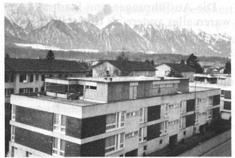
Sanierte Flachdächer an der Hallerstrasse in Thun.
