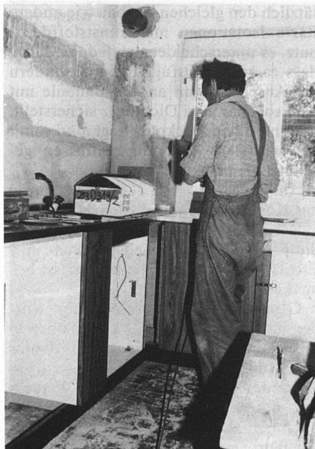
Auch die Kleinwohnungen erhalten moderne Küchen.
