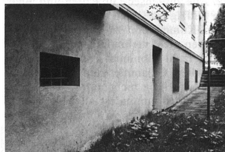
25 Jahre nach Mauerentfeuchtung
