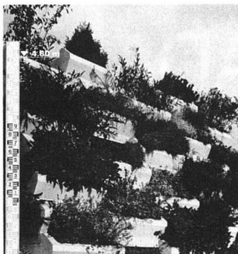
lebendiges Schattenspiel. Ein optimales Pflanzenwachstum ist gewährleistet. Zur Vereinfachung des Versetzvorganges ist der Stein mit Seitennocken versehen. Eine Böschungsneigung über  $70^{\circ}$  wird damit ausgeschlossen. Die Seitennocken verhindern das seitliche Abrutschen des eingefüllten Erdmaterials.
