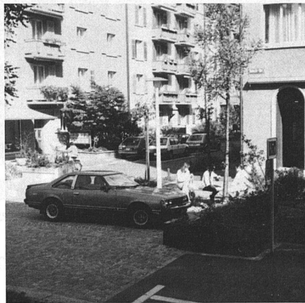
Verengungen vor der Einfahrt in die Wohninsel, Kennzeichnung als Wohnstrasse.
