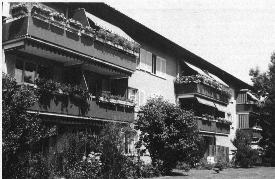
Unsere Bilder zeigen die nachträglich angebauten Balkone einer älteren, kürzlich sanierten Überbauung der Baugenossenschaft Halde in Zürich-Altstetten
