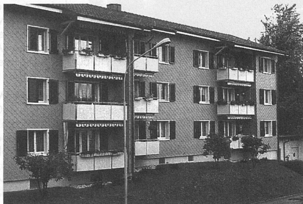
MFH Einsiedlerstrasse, Oberrieden/ZH
