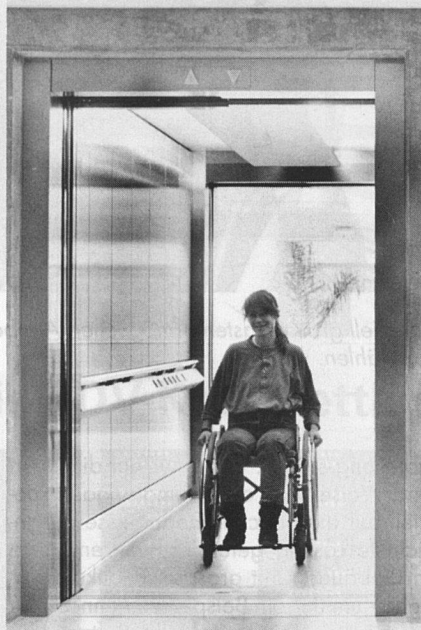
Haltestangen in der Kabine und genügend Platz erleichtern Rollstuhlfahrern das selbständige Benutzen des Aufzugs.
