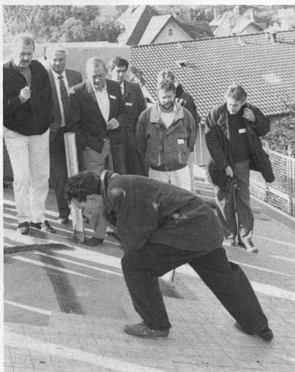
Demonstration der neuen, vollflächigen Verlegungsart von Dämmplatten am Steildach.
