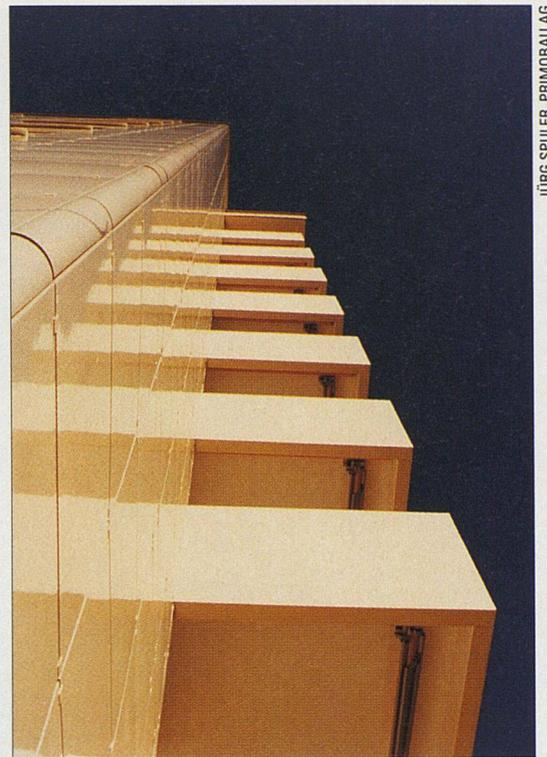
Das Hochhaus der Baugenossenschaft Halde in Zürich steht mit einem neuen Kleid da. In siebenmonatiger Umbauzeit wurde die gesamte Fassade erneuert und isoliert. Als Oberflächenmaterial wurden vorgehängte Keramikplatten gewählt.
