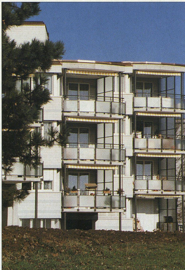
Neue Aussichtsbalkone vor den Wohnküchen.
