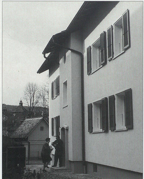
Nach jahrzehntelanger falsch verstandener Vermietungspolitik stehen heute die Wohnhäuser der WBG Laufen in neuem Gewand da.
