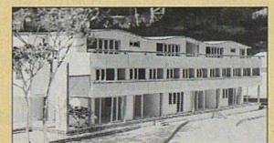
bau und sämtliche Fassaden werden als Holzrahmenbauten teilvorfabriziert.
