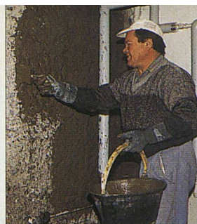
Drei Schichten Penetrat-Mörtel schützen Mauern vor Feuchtigkeit.
