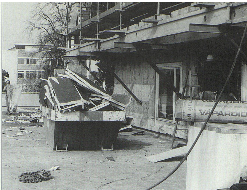
Beim Abbruch müssen mehrere Mulden bereitstehen, damit das anfallende Material richtig sortiert werden kann: brennbar/nicht brennbar, unschädlich für den Boden ...
