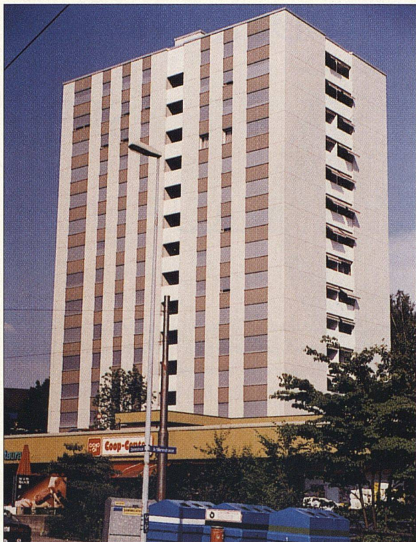
Hochhaus «Alpenblick», eine Liegenschaft der IGS Immobilien-genossenschaft Schaffhausen
