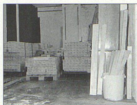
Fertig zugeschnitten stehen die Holzteile bereit . . .
