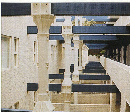
Den Lagerhäusern wurde ein Innenhof verpasst und damit eine zweiseitige Belichtung der neuen Wohnungen erreicht. (Fotos: Bruno Burri)
