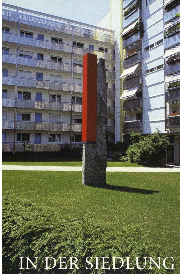
Die Farbgebung der Fassade und die Skulptur im Hof der Siedlung Industrie IV der BEP stammen von Gottfried Honegger.
