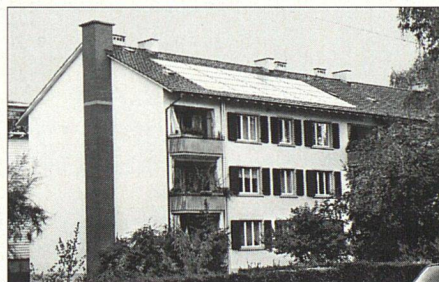
Solare Warmwasservorwärmung an der Rauracherstrasse 7-17 in Riehen
