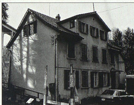
Sittertalstr. 21 in St. Gallen vor der Sanierung – ein Projekt von «Hausen und Wohnen».
